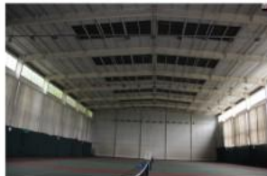
旧网球馆维修前照片
